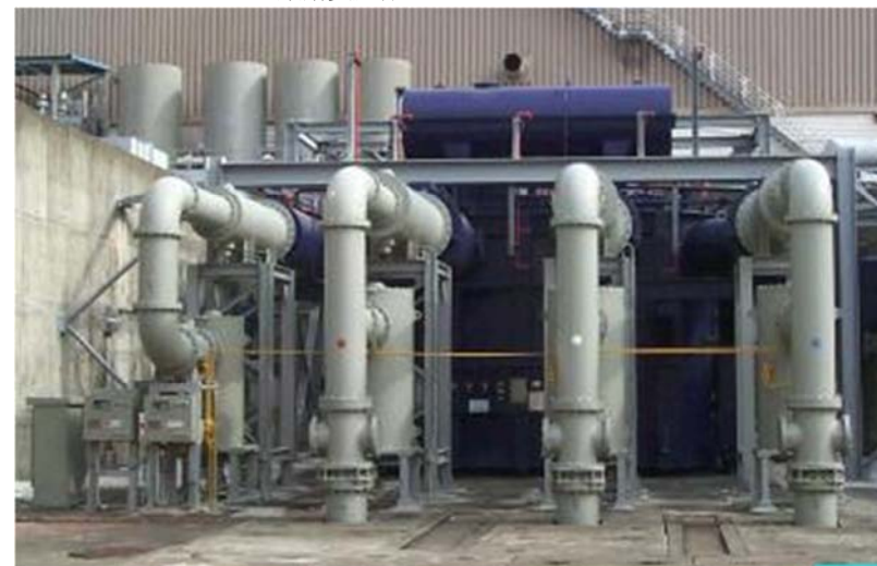
345kv啟動變壓器
