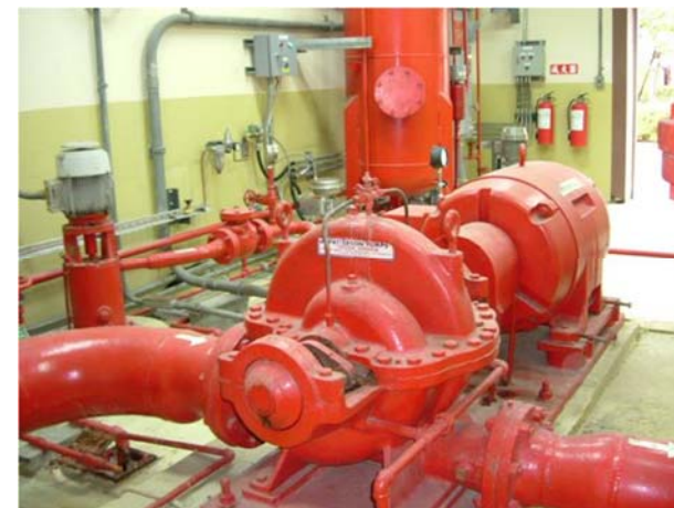
馬達帶動消防泵（一台）：KC-P143(圖四)
