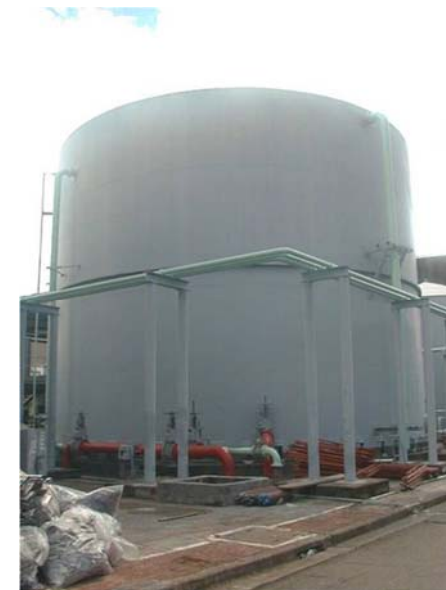
消防及補充水儲存槽(Fire & Make up Storage Tank) (圖二)
