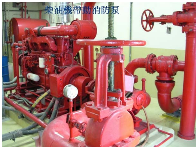
柴油機帶動消防泵（二台）：KC-P142、KC- P144(圖五)
