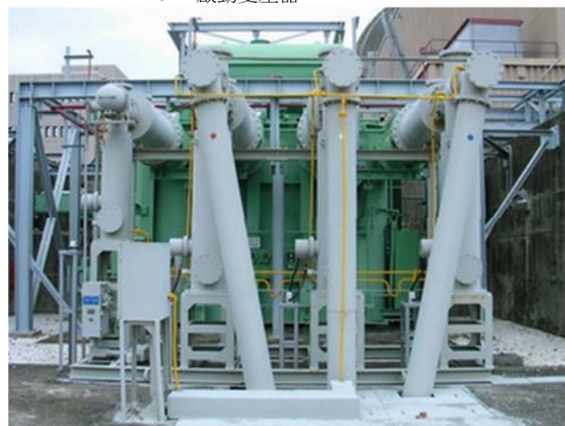
161kv啟動變壓器
